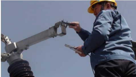
第一步 测量触头的宽度 a
