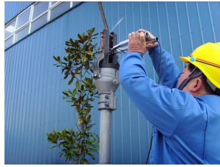
第三步 测量触指压力(未挂静触头)
