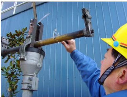
第一步 测量触头的宽度 a
