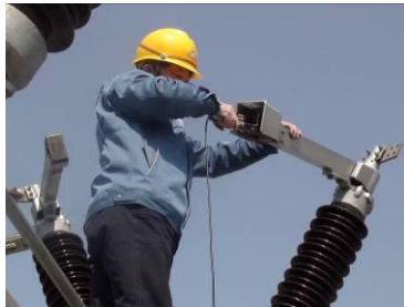
第三步 测量触指压力
