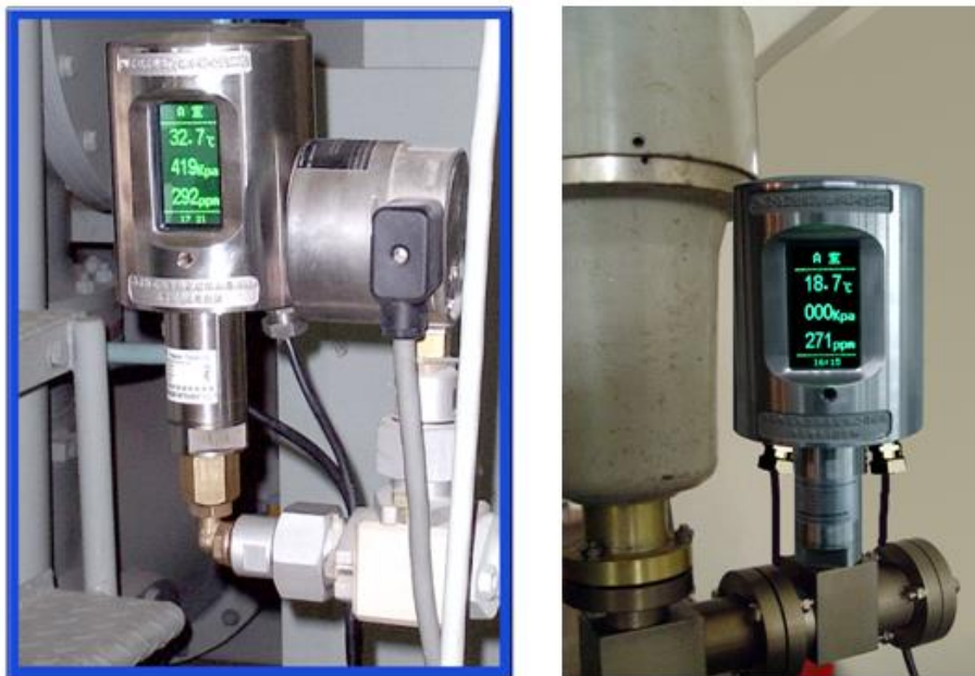
图三、安装现场照片
