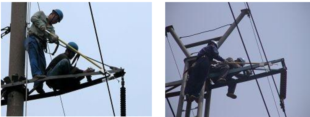
图 5-1 憎水性带电检测操作图片
